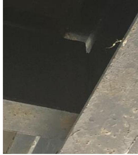
Viga secundária com apoio rotulado
