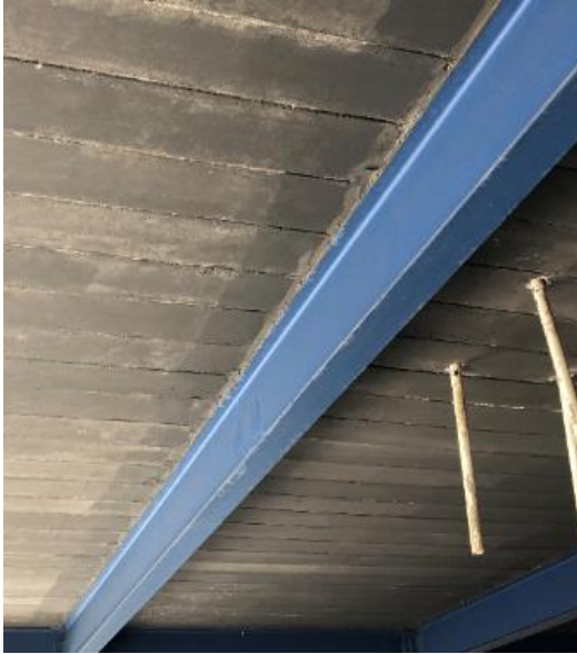
Viga secundária com apoio rotulado
